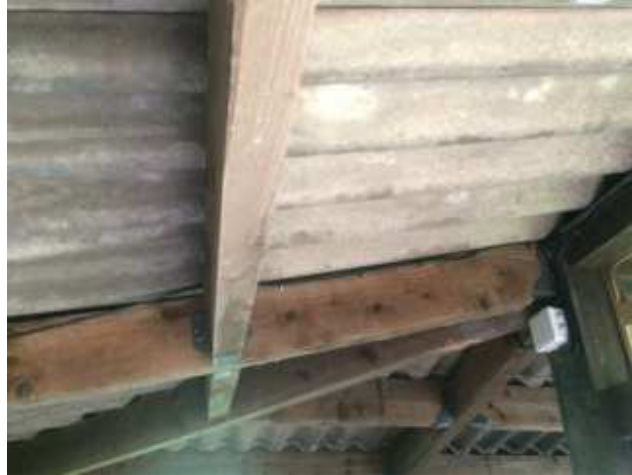
24 Appentis - Remise \ Réf: R1 Plaques Toitures
