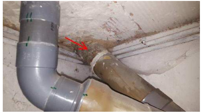
002 : fibre ciment Buanderie
