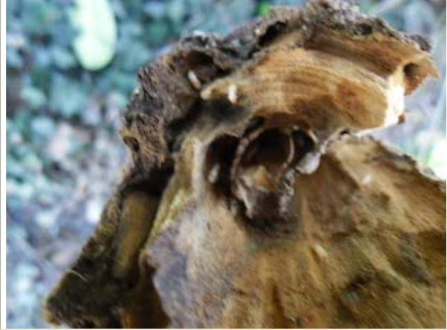
Présence de termites sur piquet
