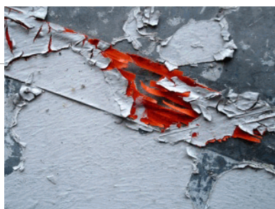
Exemples de revêtements dégradés représentant un risque pour la santé
