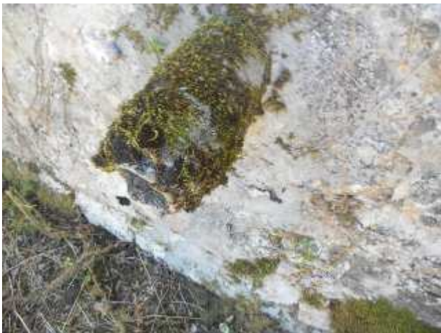
018 - Maison - Murs de Facade PHDF1 : Conduit d'évacuation eaux usées en fibres ciment
