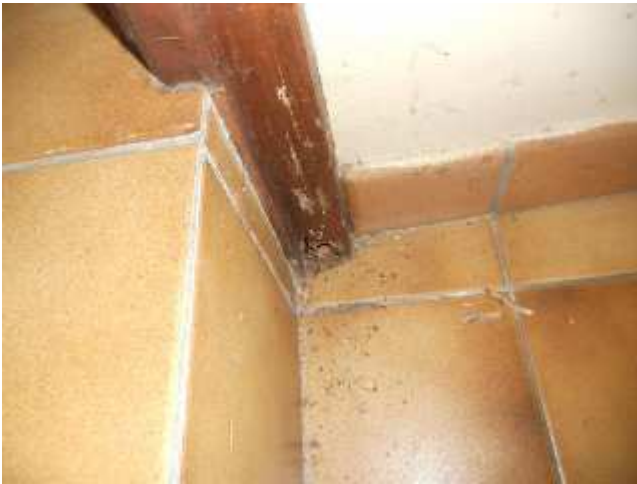
INS001 Maison - Cuisine PHDF2 : huisseries de porte Termites de bois sec
