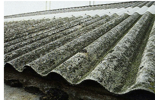
Exemples de produits contenant de l'amiante
