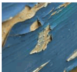
Exemples de revêtements dégradés représentant un risque pour la santé. Plaquette d'informations disponible sur : http://www.sante-sports.gouv.fr
