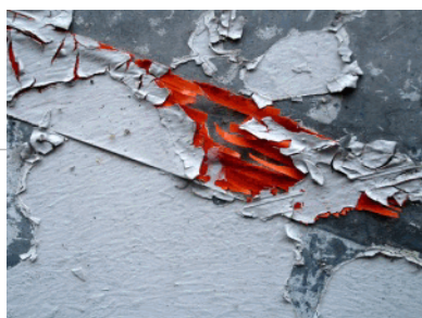
Exemples de revêtements dégradés représentant un risque pour la santé. Plaquette d'informations disponible sur : http://www.sante-sports.gouv.fr
