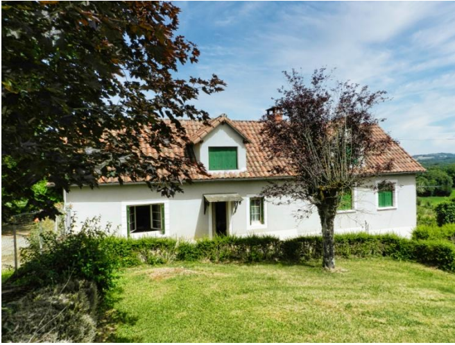
Façade sud est
