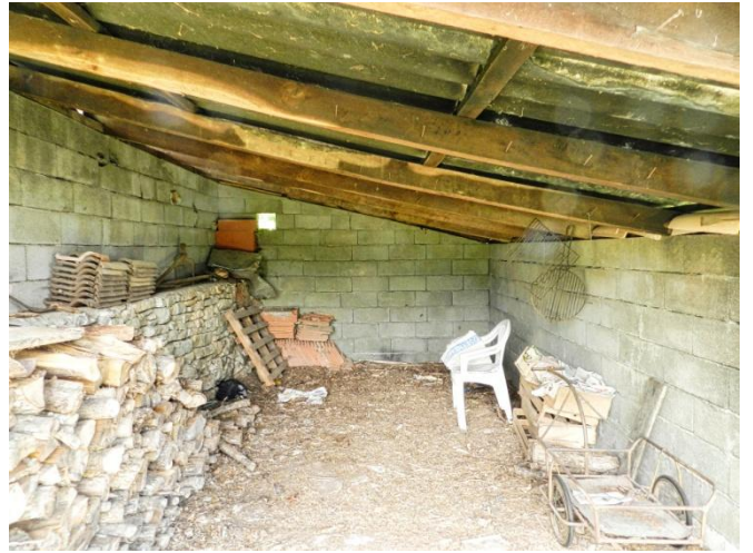
Appentis four à pain
