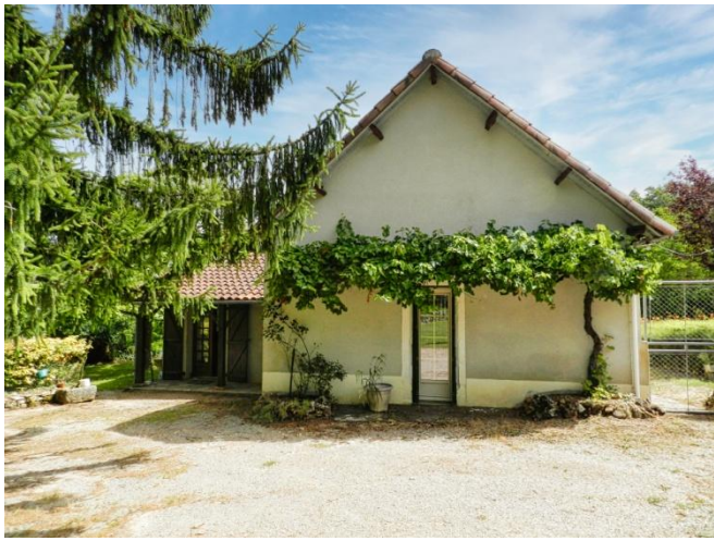
Pignon sud ouest
