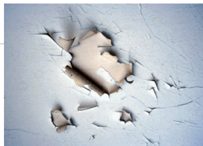
Exemples de revêtements dégradés représentant un risque pour la santé
