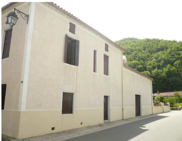
Maison de centre de village sur 2 niveaux
