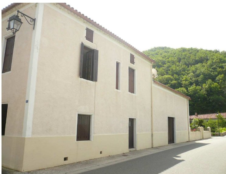
Maison de centre de village sur 2 niveaux
