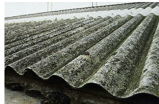
Exemples de produits contenant de l'amiante
