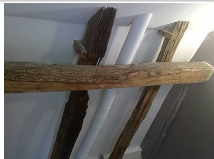
Photo n° PhA008 Localisation : 1er étage - Chambre 2 Ouvrage : Conduits de fluides (air, eau, autres fluides) Partie d'ouvrage : Conduits Description : Conduits
