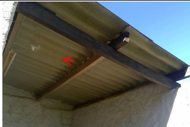
002 : Plaques ondulées Dépendances/abri bois Dépendances/abri bois (niv:0)
