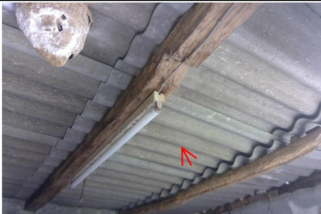
001 : Plaques ondulées Dépendances/Abri Dépendances/Abri (niv:0)
