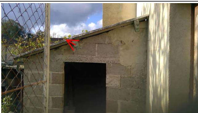
003 : Plaques ondulées en couverture Dépendance/Remise Dépendance/Remise (niv:0)
