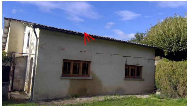
002 : Plaques ondulées en couverture Dépendance/Garage annexe Dépendance/Garage annexe (niv:0)
