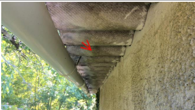
001 : Plaques ondulées en couverture lot de 3 garages (niv:0)
