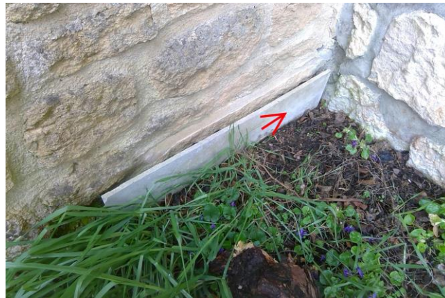
001 : Coffrage perdu Mur extérieur Mur extérieur (niv:Ext)
