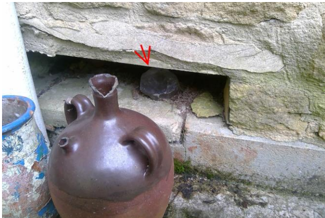
001 : Coffrage perdu Mur extérieur Mur extérieur (niv:Ext)
