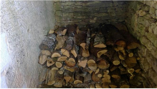
INS003 Maison - Bûcher PH:20220503-094516 encombrement trop important
