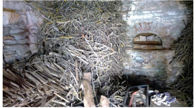
INS003 Maison - Bûcher PH:20220503-102630 encombrement trop important
