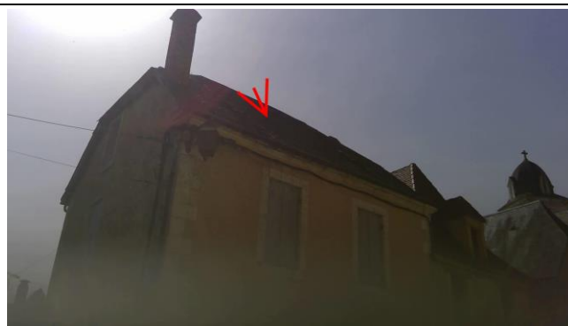
004 : Plaques ondulées en couverture Grenier Grenier (niv:2) - PRE:ML001
