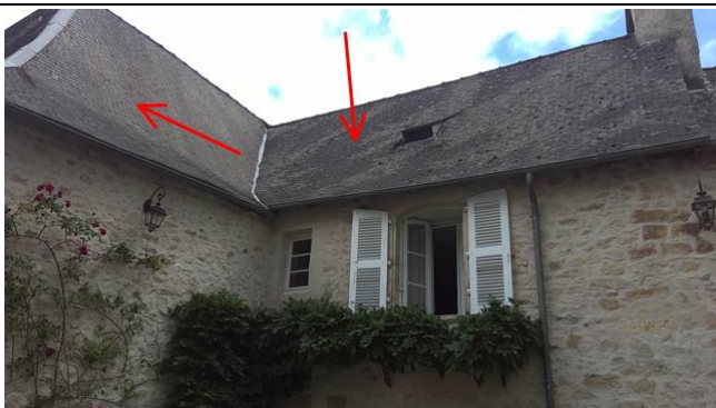
001 : Ardoises fibro-ciment Grenier
