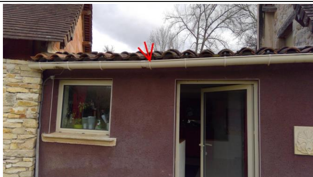
001 : Plaques ondulées en couverture Cuisine - PRE:001
