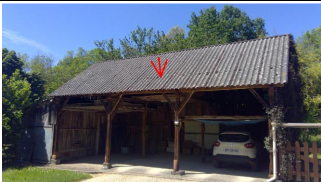
001 : Plaques ondulées en couverture Annexes/Hangar
