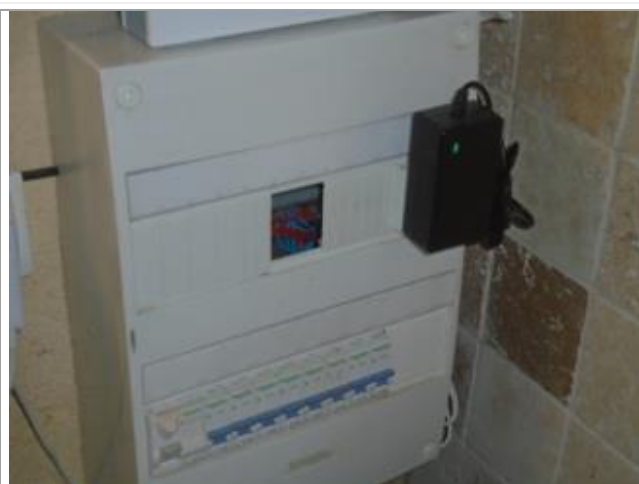
2 ème tableau de protection (pour l'extérieur)
