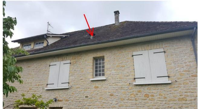
**002 : Conduit ventilation en fibre-ciment
