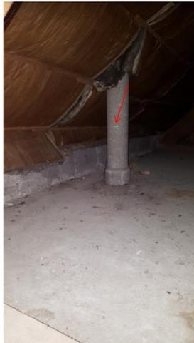
**002 : Conduit ventilation en fibre-ciment
