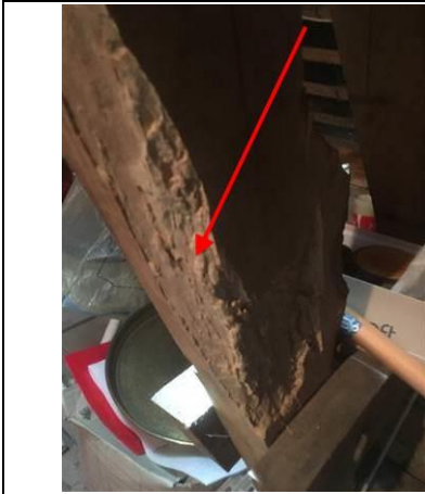
Photo n° PhTer001 Localisation : R+1 - Combles Ouvrage : Charpente bois : Pannes, pannes sablières et chevrons Parasite : ---- Insectes à larves xylophages ----, Capricornes des maisons (Hyloterpes bajulus)
