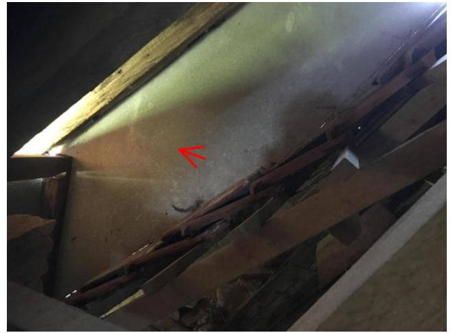
002 : amiante ciment habitation/Grenier
