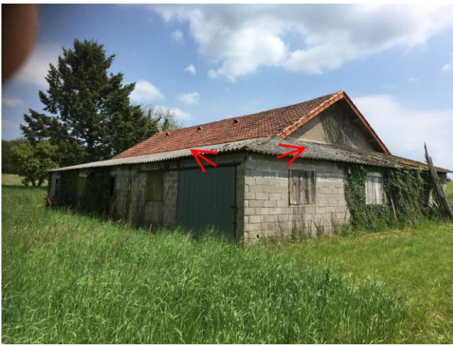
004 : Plaques ondulées en couverture dépendance/Appentis séchoir 2
