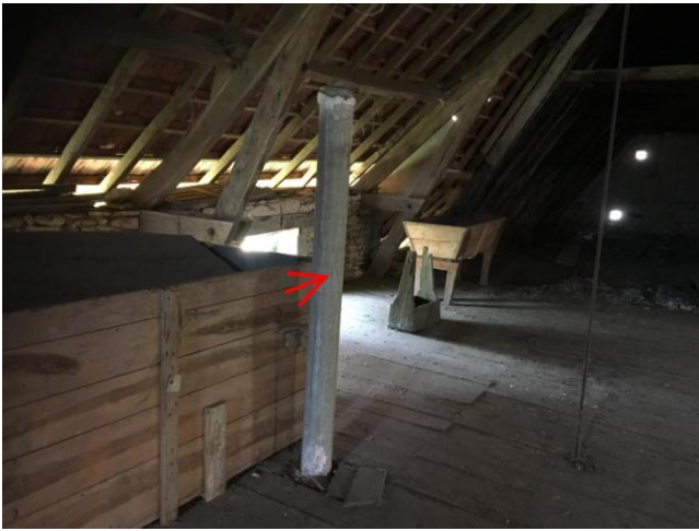
001 : Plaques ondulées en couverture habitation/Grenier
