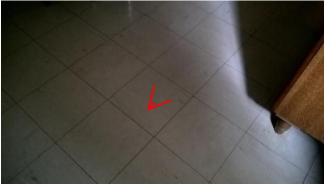
001 : Dalles de sol Cuisine 2 - PRE:001
