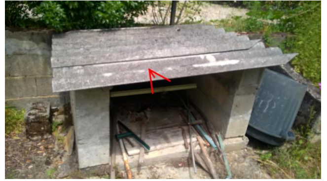
002 : Plaques ondulées fibres ciment Dépendance/Niche
