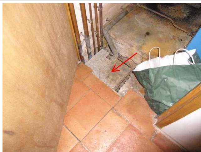
003 : Plaque en fibre-ciment Maison principale/Chaufferie
