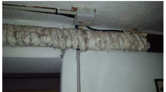
004 : Calorifugeages Garage
