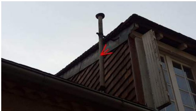
003 : fibre ciment Toiture
