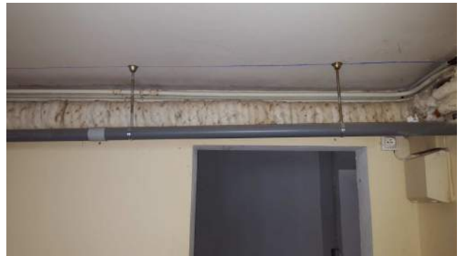
006 : Calorifugeages pièce
