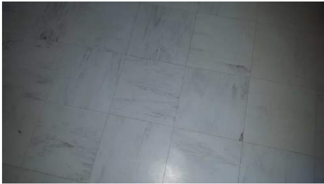
001 : Dalles de sol Salle de bain
