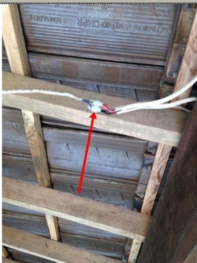
Description : L'installation électrique comporte des connexions dont les parties actives nues sous tension sont accessibles.
