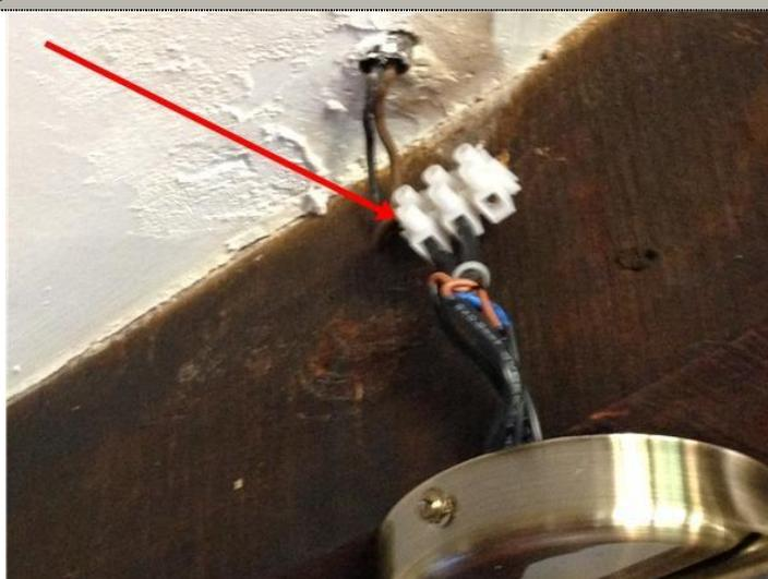
**Description :** L'installation électrique comporte des connexions dont les parties actives nues sous tension sont accessibles.
