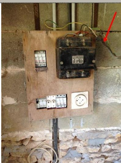
**Description :** Des conducteurs isolés ne sont pas placés dans des conduits, goulottes ou plinthes en matière isolante jusqu'à leur pénétration dans le matériel électrique qu'ils alimentent.
