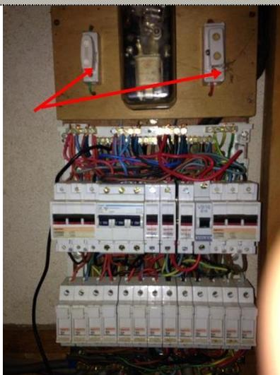
**Description :** Le type des fusibles n'est plus autorisé (fusible à tabatière, à broches rechargeables, coupe-circuit à fusible de type industriel, disjoncteur réglable en courant protégeant des circuits terminaux).
