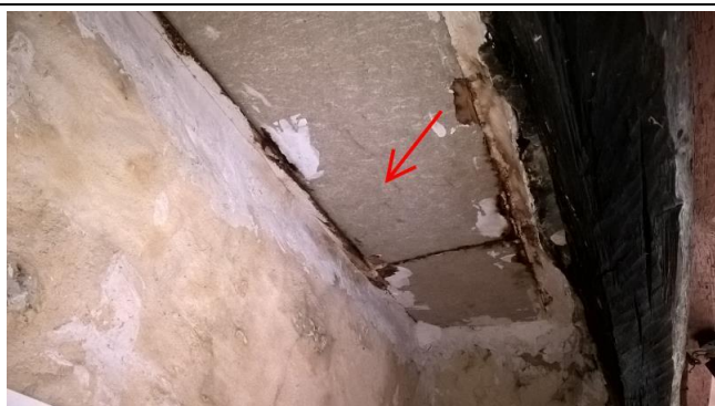
001 : amiante ciment Cuisine
