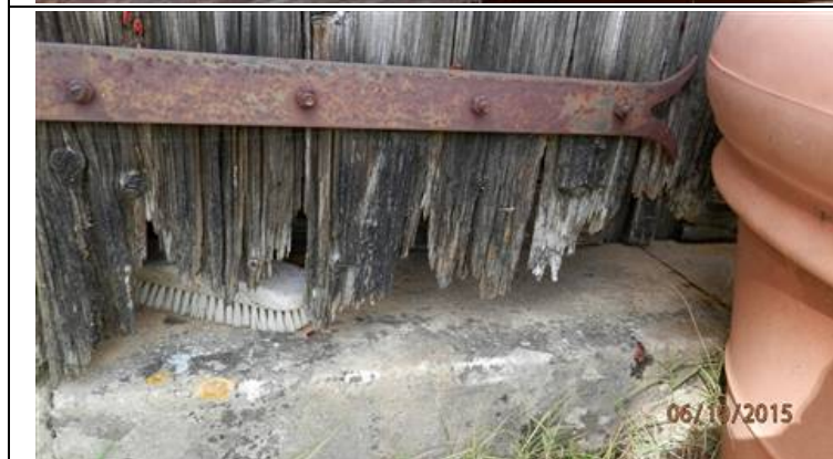
Photo n° DSCNter005 Localisation : MAISON RDC Ouvrage : Les Volets (TOUS) Parasite : Champignons de pourriture fibreuse, Capricornes des maisons (Hylotrupes bajulus) Indices : décoloration du bois (élément(s) fortement dégradé(s)) Localisation sur croquis : Point006
