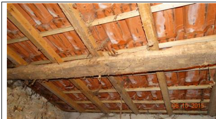
Photo n° DSCNTER001 Localisation : ANNEXES - Cave Ouvrage : Plafond, Poutres, Parasite : Anobium punctatum (Petites vrillettes), Capricornes du chêne (Hesperophanes cinereus) Indices : dégradation du bois, présence de trous de sortie (élément(s) faiblement dégradé(s)) Localisation sur croquis : Point002
