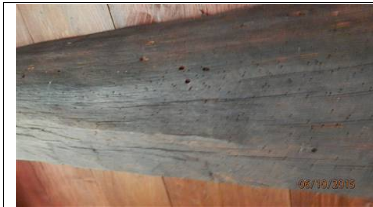
Photo n° DSCNter003 Localisation : MAISON RDC - Salle à manger Ouvrage : Plafond, Poutres et Plancher Haut, Parasite : Anobium punctatum (Petites vrillettes), Capricornes des maisons (Hylotrupes bajulus) Indices : dégradation du bois, présence de trous de sortie (élément(s) faiblement dégradé(s)) Localisation sur croquis : Point004
