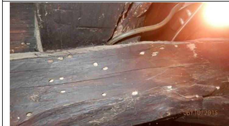
Photo n° DSCNter004 Localisation : ETAGE - Couloir Ouvrage : Plafond, Poutres. Parasite : Capricornes des maisons (Hylotrupes bajulus) Indices : dégradation du bois, présence de trous de sortie (élément(s) faiblement dégradé(s)) Localisation sur croquis : Point005
