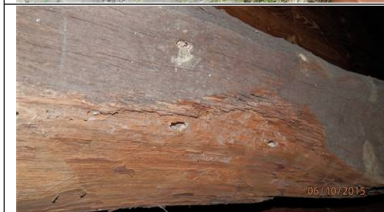
Photo n° DSCNter006 Localisation : ETAGE - Chambre 2/3/4 Ouvrage : Plafond, Poutres. Parasite : Capricornes des maisons (Hylotrupes bajulus) Indices : dégradation du bois, présence de trous de sortie (élément(s) faiblement dégradé(s)) Localisation sur croquis : Point007
