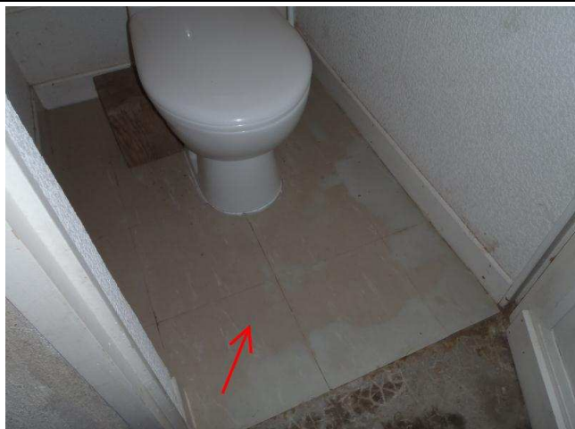
001 : Dalles de sol Toilette
