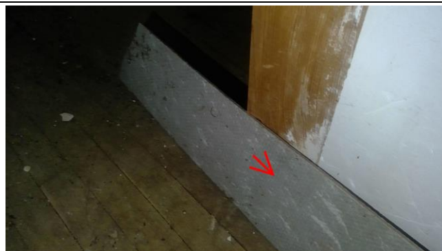
004 : amiante ciment Placard
