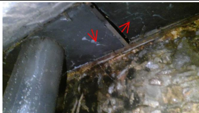
006 : amiante ciment Cuisine
