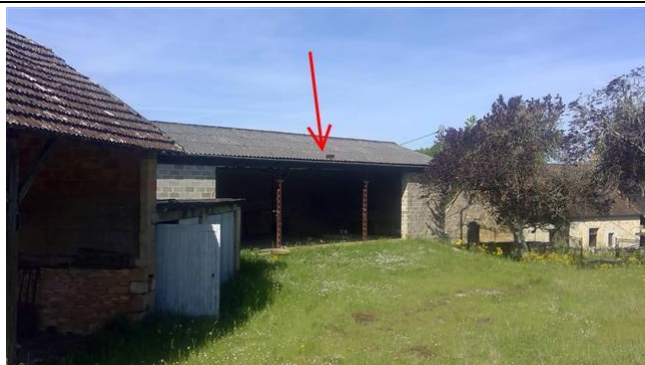
007 : amiante ciment Dépendances/Hangar
