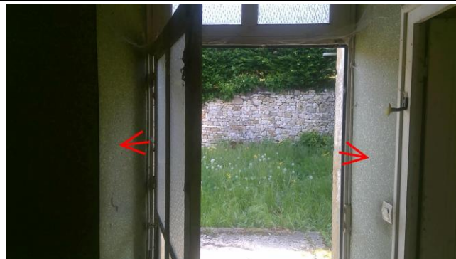
002 : amiante ciment Dégagement Escalier
