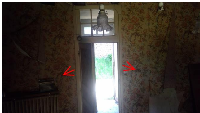
001 : amiante ciment Cuisine
