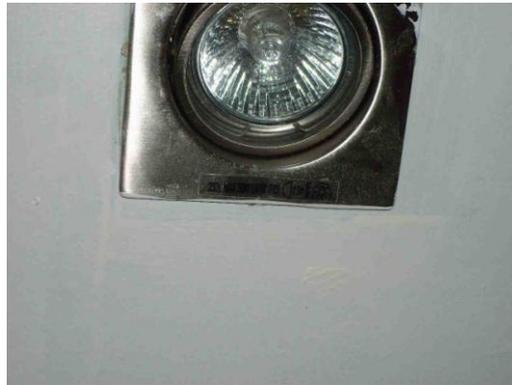
Description : Local contenant une baignoire ou une douche : l'installation électrique ne répond pas aux prescriptions particulières appliquées à ce local (adéquation entre l'emplacement où est installé le matériel électrique et les caractéristiques de ce dernier – respect des règles de protection contre les chocs électriques liées aux zones).
