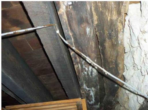
**Description :** Des conducteurs isolés ne sont pas placés dans des conduits, goulottes ou plinthes en matière isolante jusqu'à leur pénétration dans le matériel électrique qu'ils alimentent.
