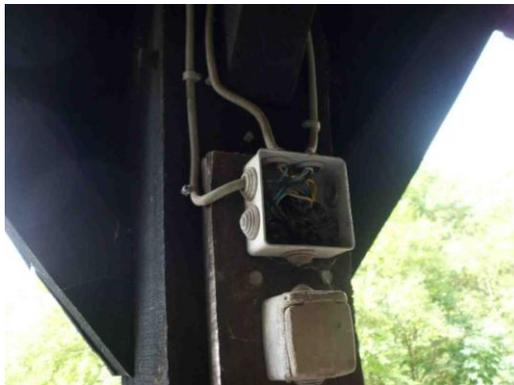
Description : L'installation électrique comporte des dispositifs de protection dont les parties actives nues sous tension sont accessibles.
