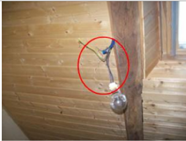
conducteurs non protégés - douille de chantier
