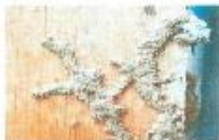
Lorsqu'ils rencontrent des matériaux trop durs, les termites les contournent en construisant des galeries faites de particules agglomérées. Ils peuvent également s'adapter et utiliser des conduits existants pour se déplacer (gainés électriques...).
