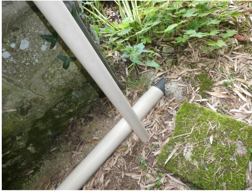
Branchement sur réseau enterré
