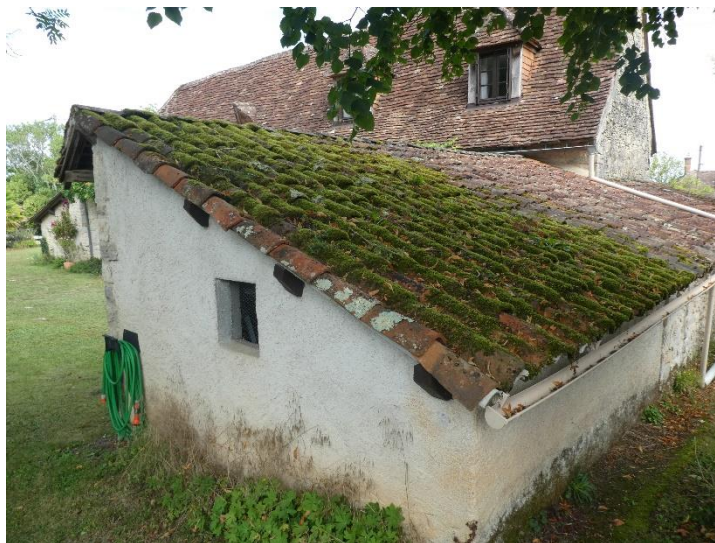
Mousse et gouttière PVC
