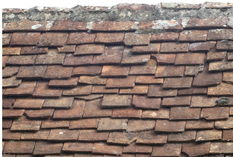
Partie courante (tuiles cassées et déplacées)
