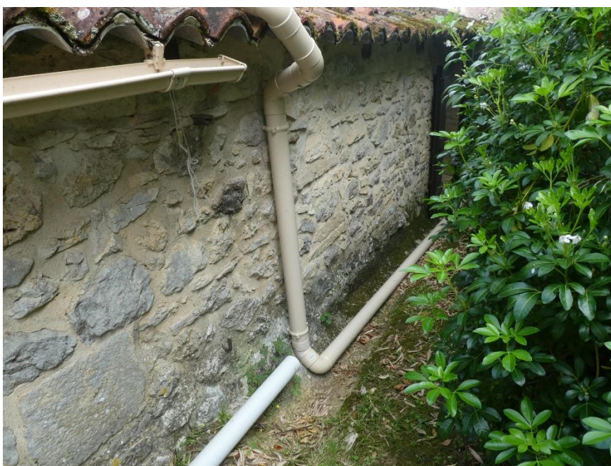
Descente EP du versant Sud
