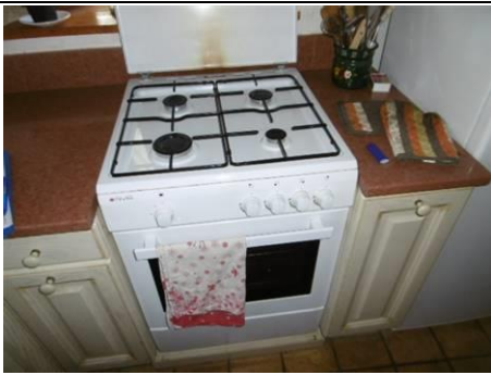
Photo n° PhGaz001 Localisation : Habitation / Rez-de-chaussée - Cuisine Cuisinière AYA (Type : Non raccordé)
