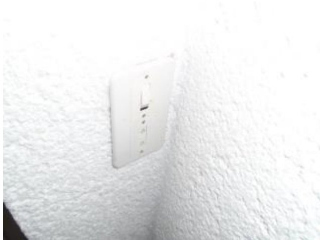
Certains circuits ne possèdent pas de broche de raccordement à la terre / Absence puit de protection et obturateur
