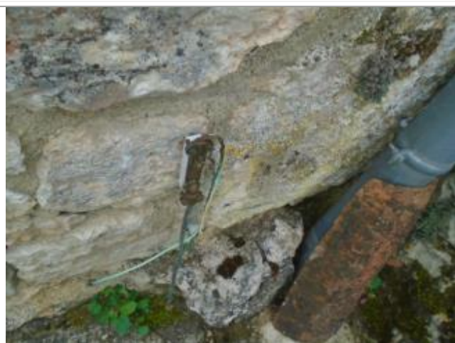
Conducteur de terre non protégé (risque d'arrachement)
