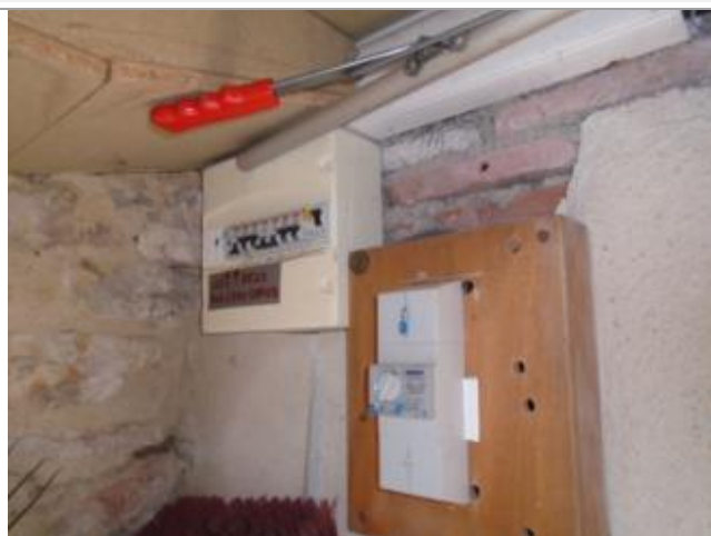
Appareil Général de Coupure et de Protection à l'extérieur du logement. Tableau de protection Annexe 2
