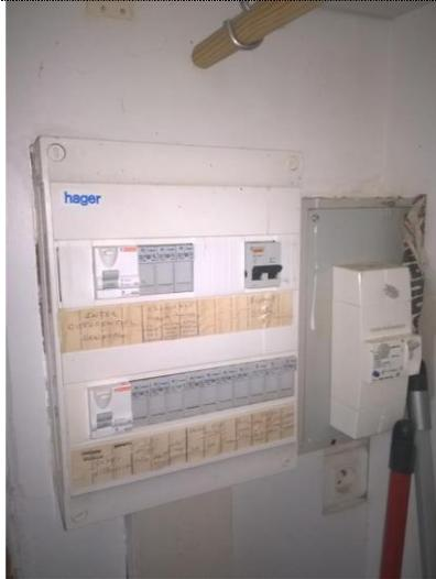
**Description :** Le courant assigné (calibre) de la protection contre les surcharges et courts-circuits d'au moins un CIRCUIT n'est pas adapté à la section des CONDUCTEURS correspondants.
