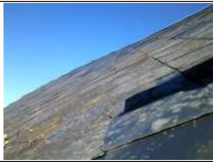
Photo n° PhA001 Localisation : Rez de chaussée - Cuisine Ouvrage : Toitures Partie d'ouvrage : Ardoises Description : Ardoises (fibres-ciment)
