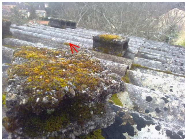
002 : Plaques ondulées en couverture Dépendance(s)/Remise de jardin
