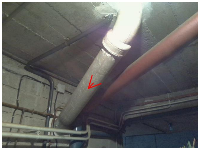
001 : Conduit ventilation en fibre-ciment Garage
