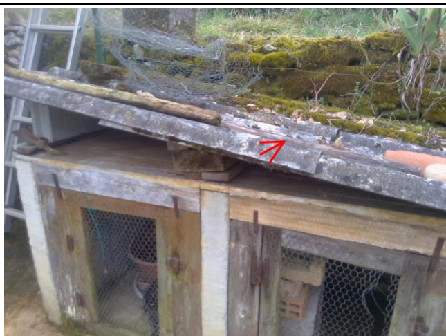
003 : Plaques ondulées en couverture Dépendance(s)/Clapier
