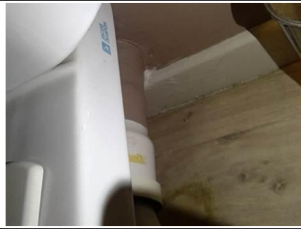
Photo n° PhA004 Localisation : 2ème étage - WC Ouvrage : Conduits de fluides (air, eau, autres fluides) Partie d'ouvrage : Conduits Description : Conduits Localisation sur croquis : M004
