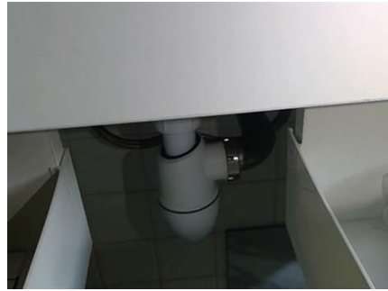
Photo n° PhA005 Localisation : 2ème étage - Salle de bains Ouvrage : Conduits de fluides (air, eau, autres fluides) Partie d'ouvrage : Conduits Description : Conduits Localisation sur croquis : M005
