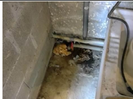
Photo n° PhA010 Localisation : RdC - Cuve à fiouls Ouvrage : Conduits de fluides (air, eau, autres fluides) Partie d'ouvrage : Conduits Description : Conduits Localisation sur croquis : M010
