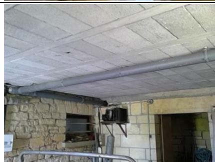
Photo n° PhA011 Localisation : RdC - Garage 2 Ouvrage : Conduits de fluides (air, eau, autres fluides) Partie d'ouvrage : Conduits Description : Conduits Localisation sur croquis : M011
