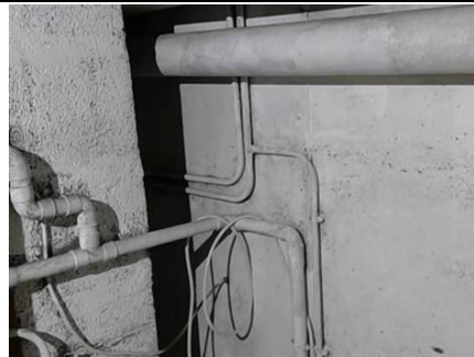
Photo n° PhA006 Localisation : RdC - Chaufferie Ouvrage : Conduits de fluides (air, eau, autres fluides) Partie d'ouvrage : Conduits Description : Conduits Localisation sur croquis : M006
